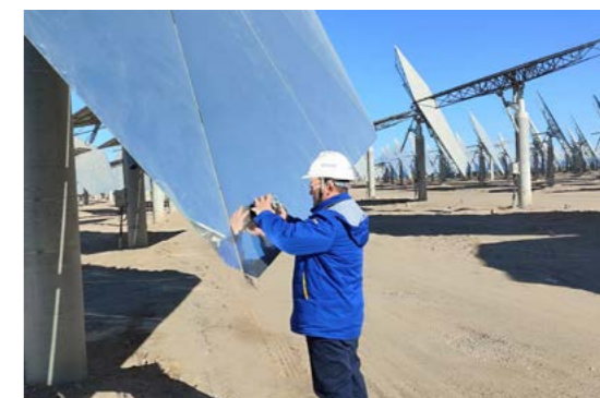
甘肃阿克塞汇东新能“光热 + 光伏”项目现场，零下 10 度的环境下，东方锅炉项目团队成员在进行定日镜清洁度抽查工作，以确保定日镜聚光反射太阳能的精确性能。
