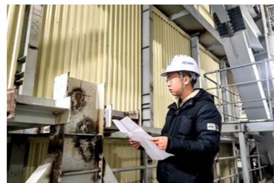
位于塔克拉玛干沙漠边缘地区的新疆和田热电项目现场，在零下 10 度至 20 度的环境下，东方锅炉项目服务人员正在为 1 号机组检查电站锅炉热态膨胀及导向装置，确保机组安全正常运行。
