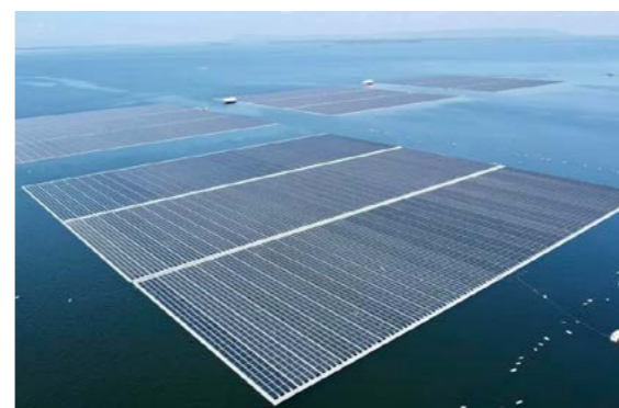
▲ 泰国乌汶叻水面光伏综合智慧能源项目实现项目全面移交
